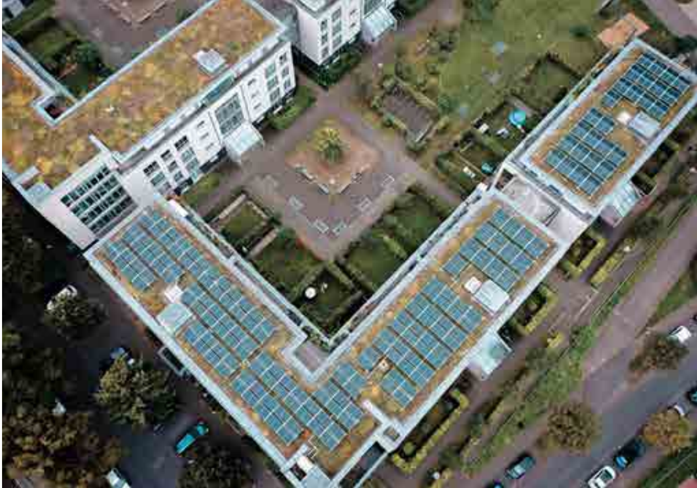
Der Vorteil im Geschosswohnungsbau: PV-Strom vom eigenen Dach kann fast vollständig direkt im Gebäude genutzt werden. Bei drei- bis viergeschossigen Gebäuden sind 2 bis 3 kW peak realistische Größen. Damit wird ein Selbstversorgungsanteil von 30 bis 40 % erreicht
