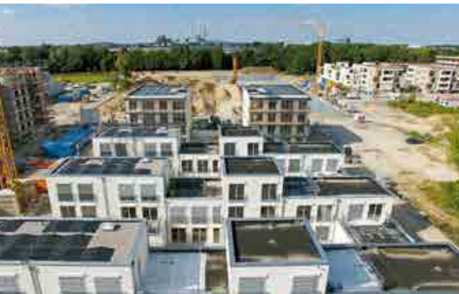
Auf dem Gelände der ehemaligen Prinz-Eugen-Kaserne entstand eine Passivhaus-Wohnanlage des Münchner Architektur- und Projektentwicklungsbüros Nest Ecoarchitektur mit 55 auf zwei Stadthäuser und vier Atriumhausriegel verteilten Mietwohnungen: PV-Anlage und Batteriespeicher versorgen Haushalte und Ladestationen
